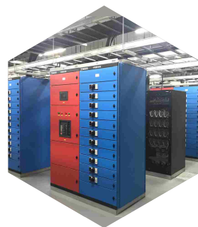
广东福能大数据产业园
